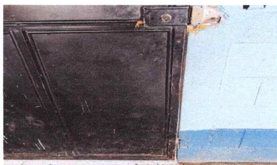
Foto 20: Sustitución de chapa. Aula modulo 2
