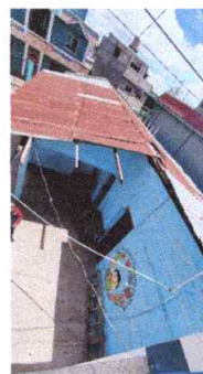
Foto 22: Sustitución de lamina por lamina troquelada. Modulo 2
