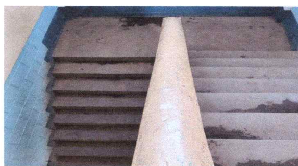
Foto 4: Sustrucción de piso torta de concreto (por ceramico) Modulo 1
