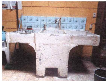
Foto 18: Sustitución de pila. Cocina
