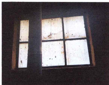
Foto 16: Sustitución de estructura de metal de ventana y sustitución de vidrios. Cocina
