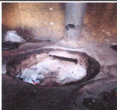
Foto 17: Mantenimiento a estufa rural. Cocina
