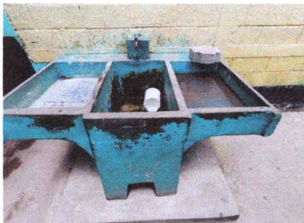
Foto 13: Sustitución de pila de cemento de dos lavaderos. Area de baños
