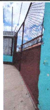
Foto 21: Sustitución de porton de metal. Patio
