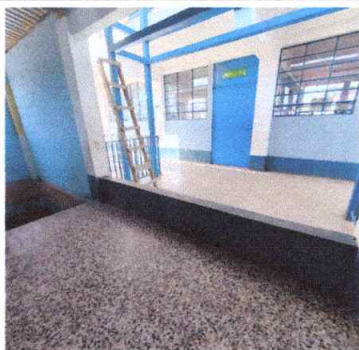
Foto 5: Demolicion de bordillo ..Modulo 1
