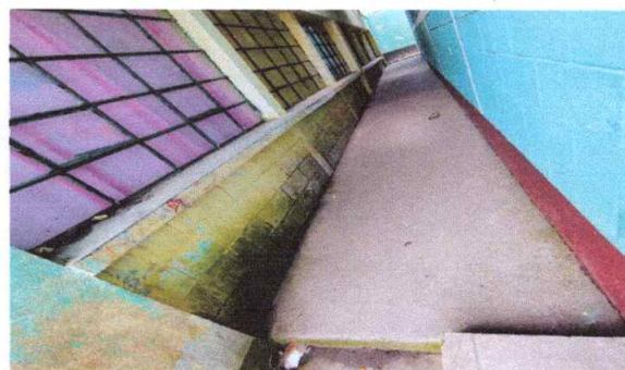
Foto 6: pintura en muros exteriores e interiores
