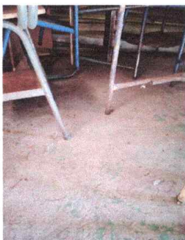
Foto 25: Sustrución de piso de torta de concreto (Por cerámico) Modulo 2
