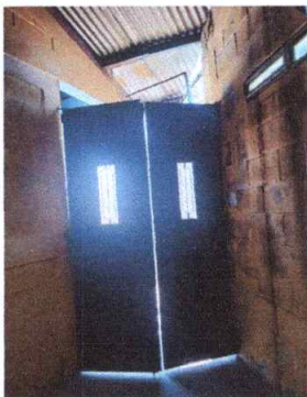
Foto 19: Mantenimiento a estructura y elaboracion de reja en el espacio de arriba, cambio de chapa y alineación porque esta desajustada.
