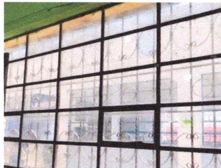
Foto 2: Mantenimiento a estructura de metal de ventana.
