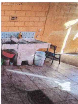
Foto 20: Sustitucion de piso de torta de concreto(por cerámico) Cocina
