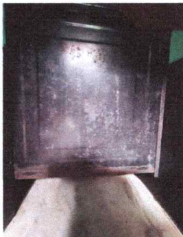
Foto 9: Mantenimiento a estructura (Fijado, cepillado, aplicación de pintura. Area de baños
