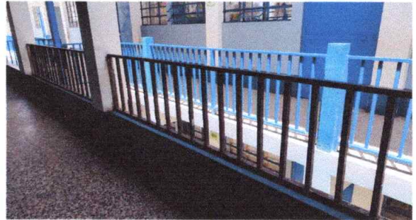
Foto 8: Mantenimiento a barandas de metal. Modulo 1
