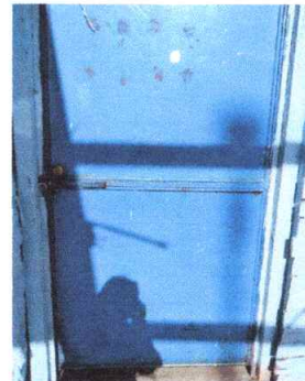
Foto 26: Sustrución de puerta. Modulo 2
