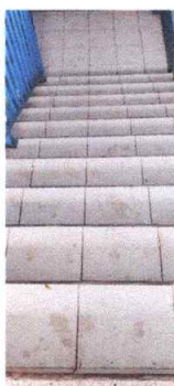
Foto 15: Sustitucion de piso (por ceramico)Modulo 2
